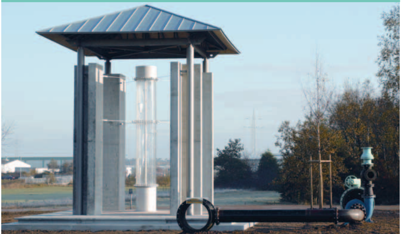
Frankfurt Rhein-Main - Dietzenbach Wassertempel
